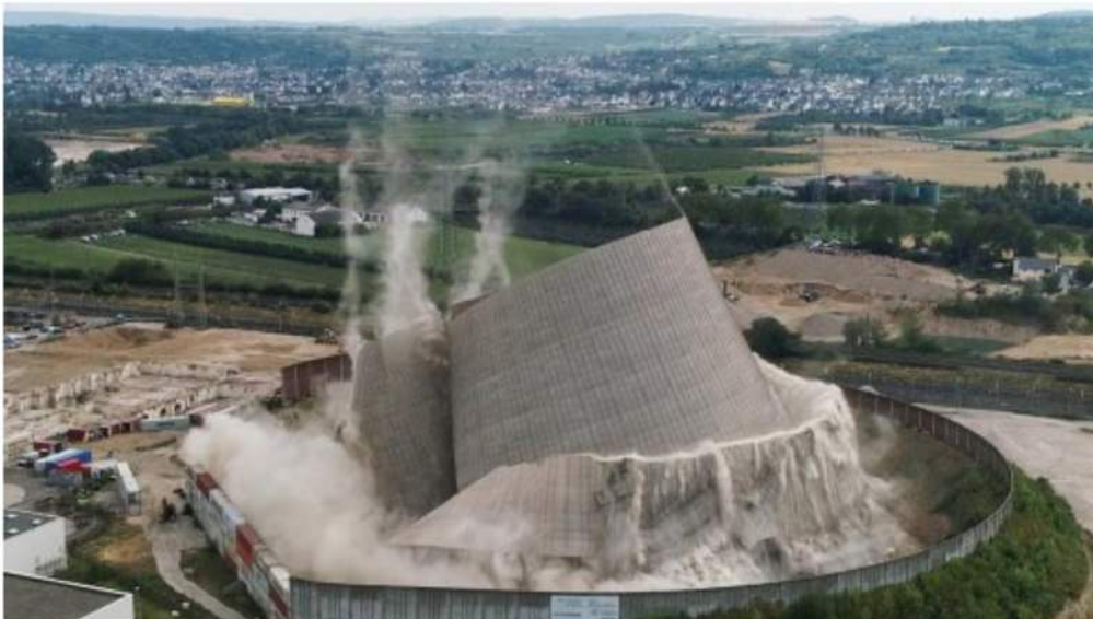
Hunderte Milliarden verschleudertes Geld: Sprengung des Kühlturms des Atomkraftwerks Mülheim-Kärlich, 2019. Bild: Keystone
