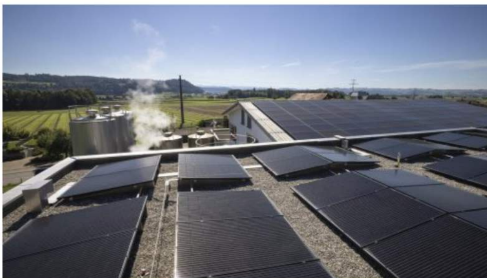
In den Wintermonaten besonders ineffizient: Solarpanels. Bild: Keystone
